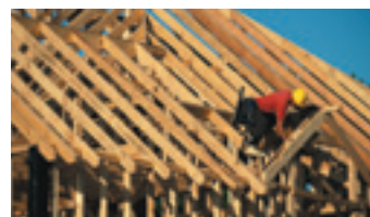
Obrero trabajando en la construcción del techo de una casa.
